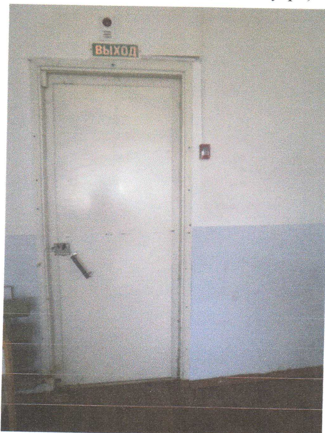
Фото №7-1. Запасный путь (вид изнутри)
