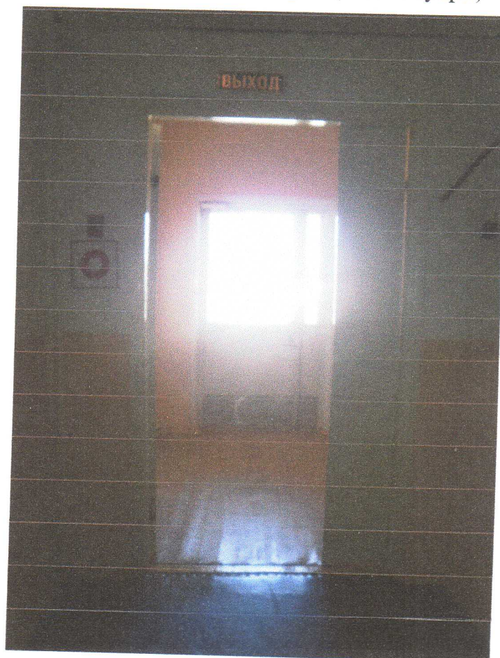
Фото №9-1. Запасный путь (вид изнутри)
